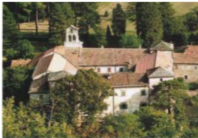
Figura 1 - Il complesso della Badia con la Chiesa
